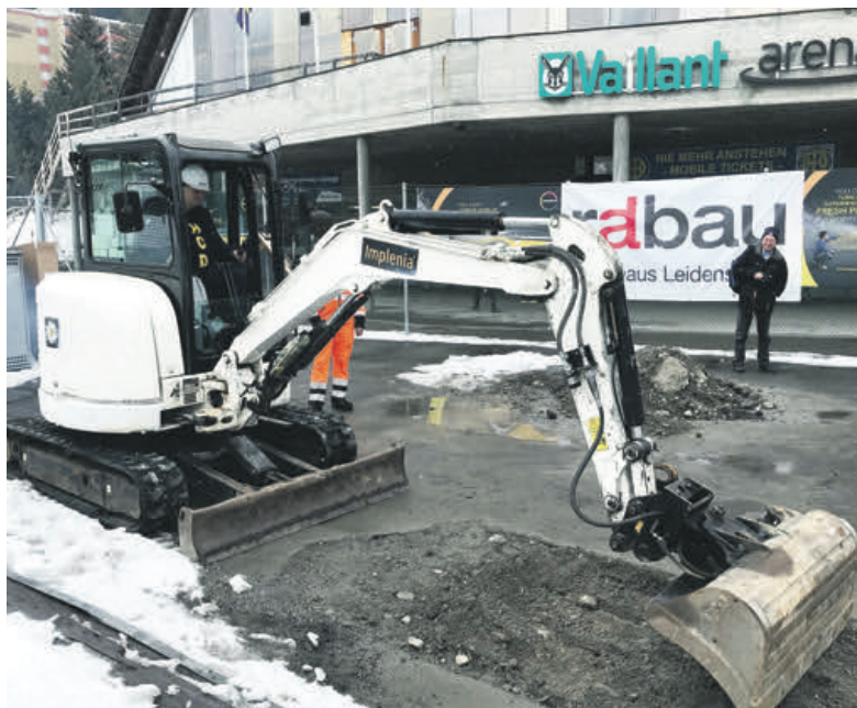
Der präsidiale Spatenstich für die Trainingshalle durch Gaudenz Domenig.
