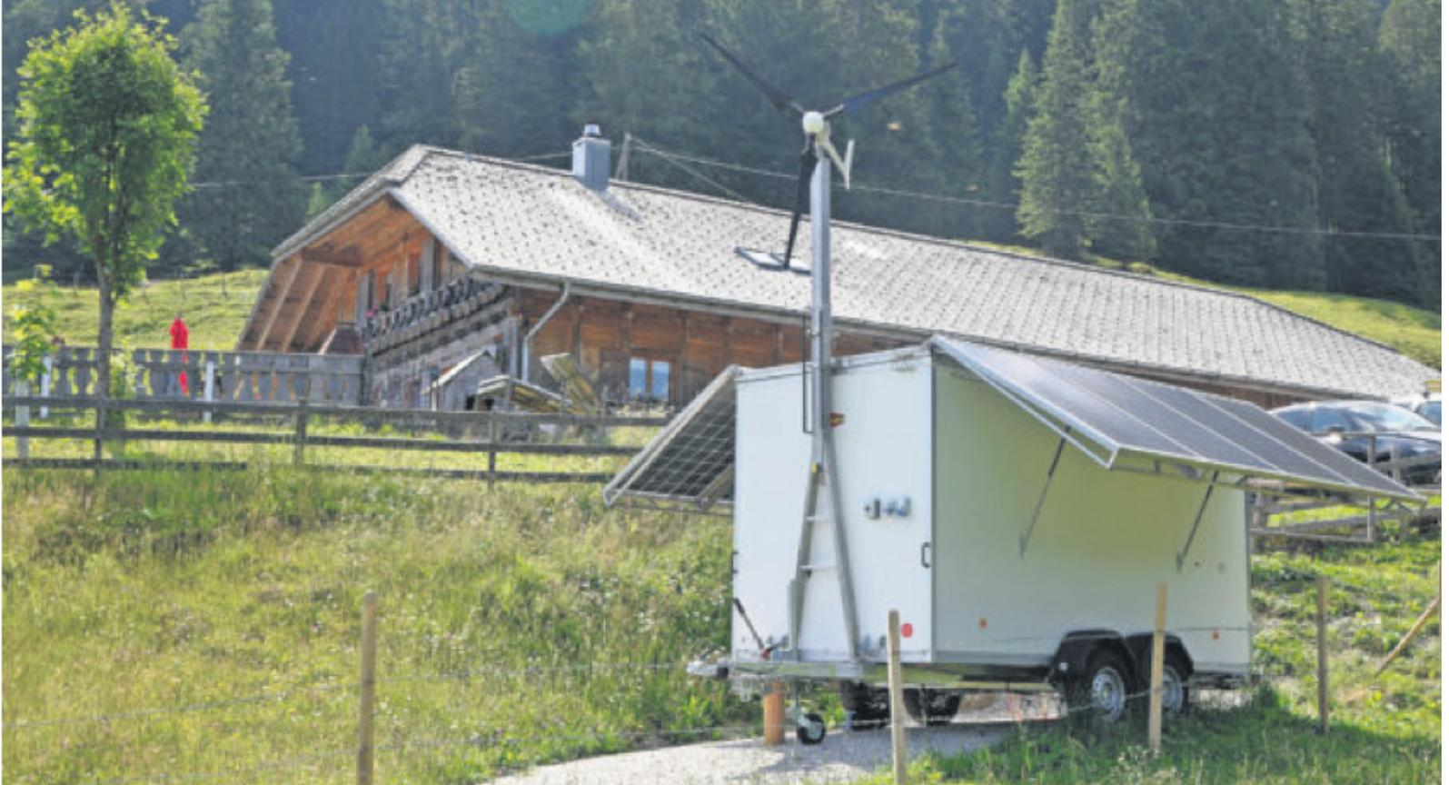
Der Solaranhänger von Clevertrailer versorgt die Alp Oschoubi im Gantrischgebiet mit Strom für Telefon, Licht, Stall- und Küchengeräte sowie für die Kühlaggregate. Komplett CO<sub>2</sub>-frei ist das «Stromwerk» eine Alternative für herkömmliche Benzinaggregate.
