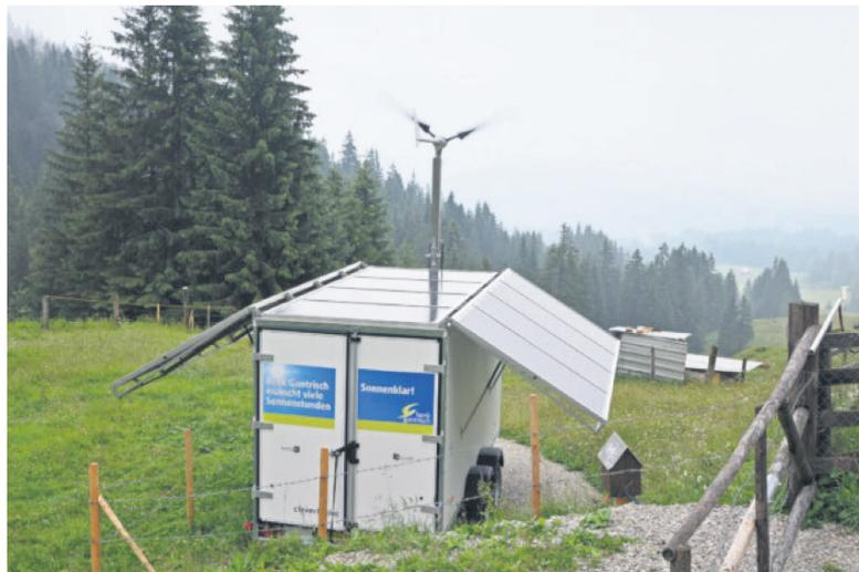
*Bei genügend Wind kann das Windrad auch bei wenig Sonne für eine Versorgung der Hauptbatterie sorgen.*
