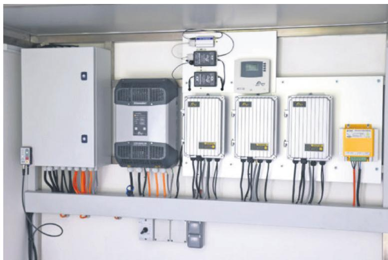
*Die Elektronik umfasst drei Solar-Laderegler, einen Wechselrichter, eine Programmier- und Fernsteuereinheit, Kommunikationsmodule und die Windregleranlage.*
