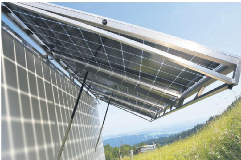
*Die seitlichen Panels sind bifacial, müssen daher ausgeklappt werden, damit das reflektierte Licht auf die hinteren Zellen treffen kann.*
