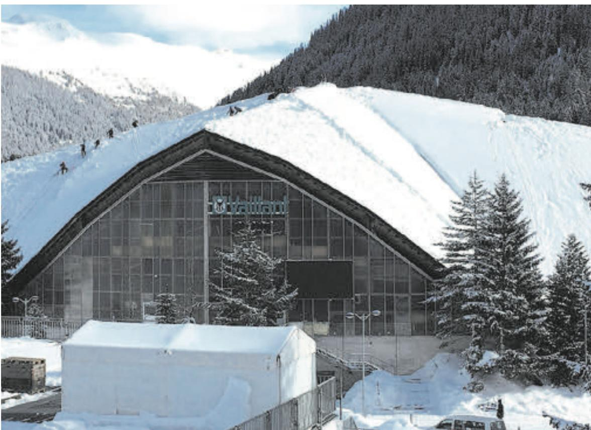
**Links:** Anfang Februar 2018 wurde grossflächig Schnee vom Dach der Vaillant-Arena abgetragen, um im Falle von weiteren grossen Schneefällen Probleme mit der Statik des Tragwerkes zu verhindern.
