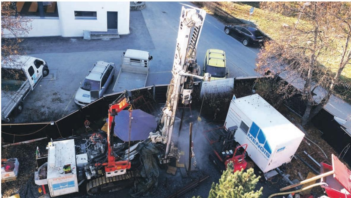
Mit einer 450 m tiefen Bohrung fördert der Wärmeverbund Arkaden lauwarmes Grundwasser und erwärmt dieses mittels einer Wärmepumpe. Auch die Schulliegenschaften in Davos Platz gehören zum Wärmeverbund und werden seit November 2020 mit erneuerbarer Energie versorgt.
