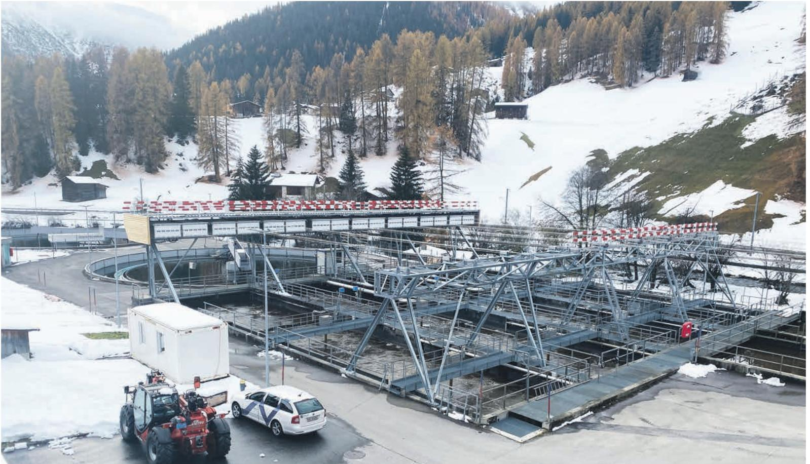
Über eine Fläche von total 2600 m<sup>2</sup> erstreckt sich das Solarfaltdach, das von einer vollautomatischen Wetterstation gesteuert wird.
