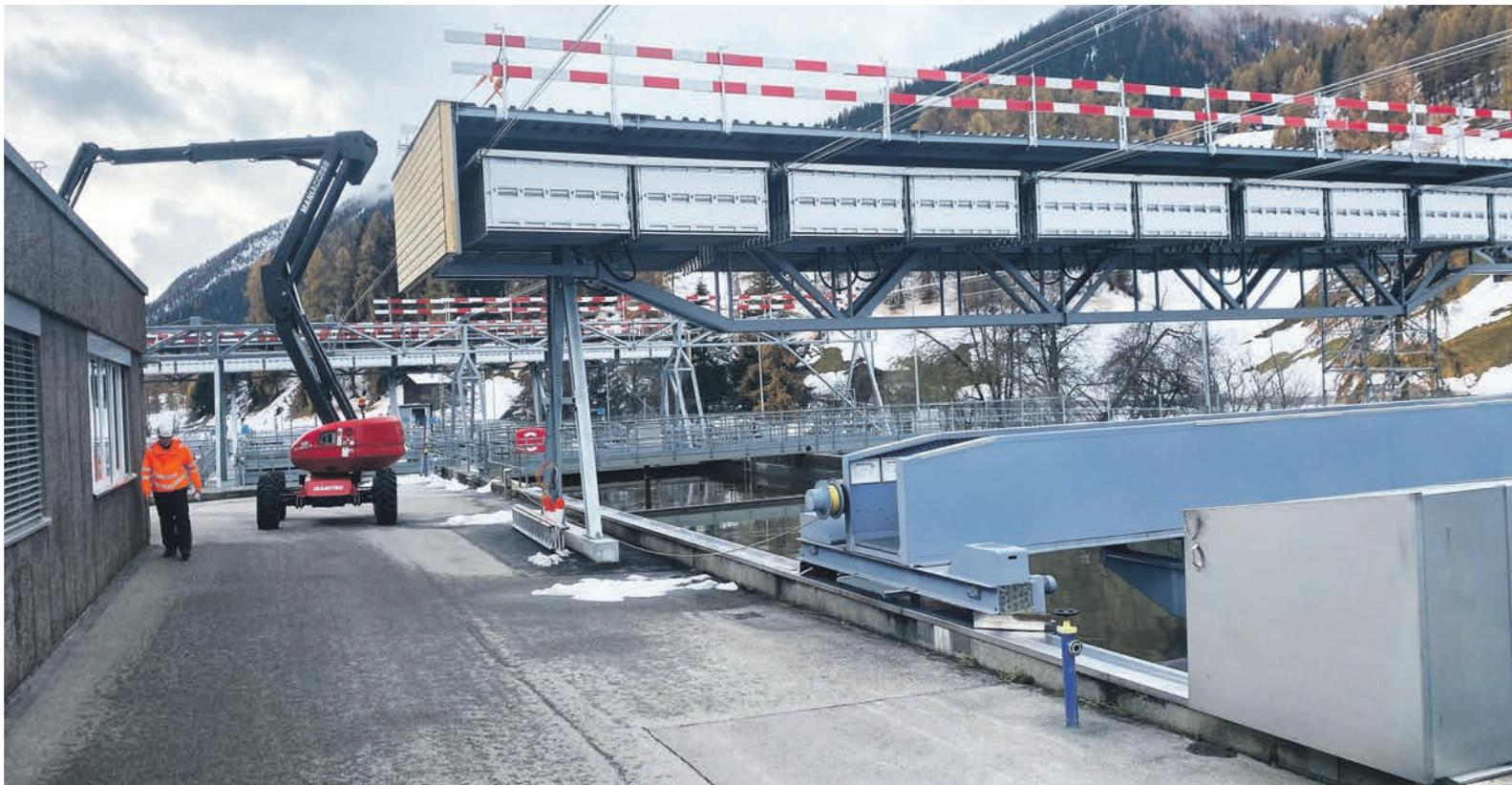
Das Solarfaltdach zieht sich bei schlechter Witterung, z.B. Schneefall, automatisch zurück. Glaris ist jedoch ein sonniger Flecken, und der Standort für dieses Solarfaltdach ist ideal.
