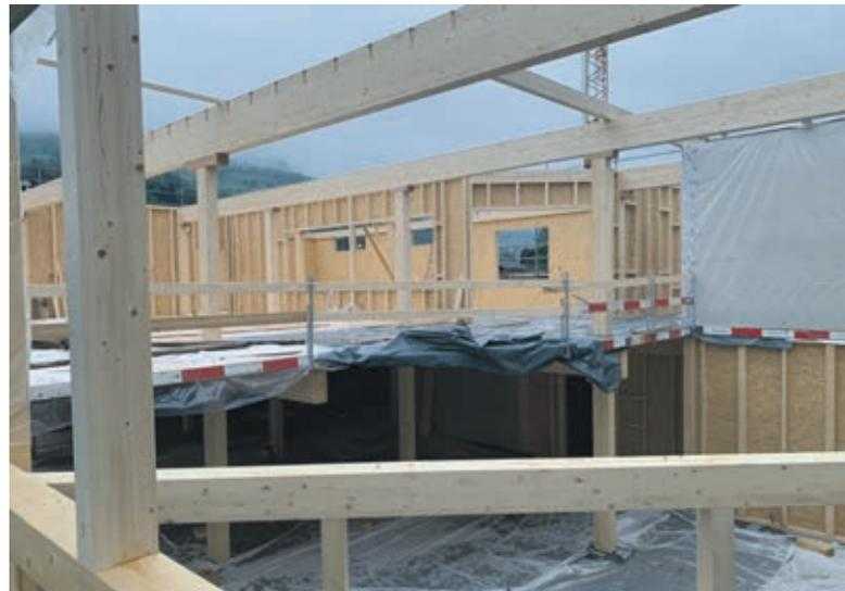
Die vorgefertigten Elemente werden montiert.
