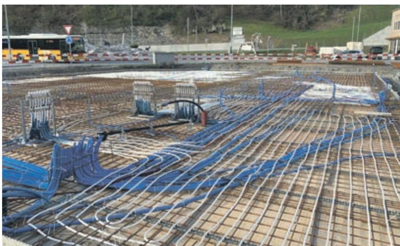
Die Monobetonplatte mit integrierter LWP-Bodenheizung wird erstellt.
