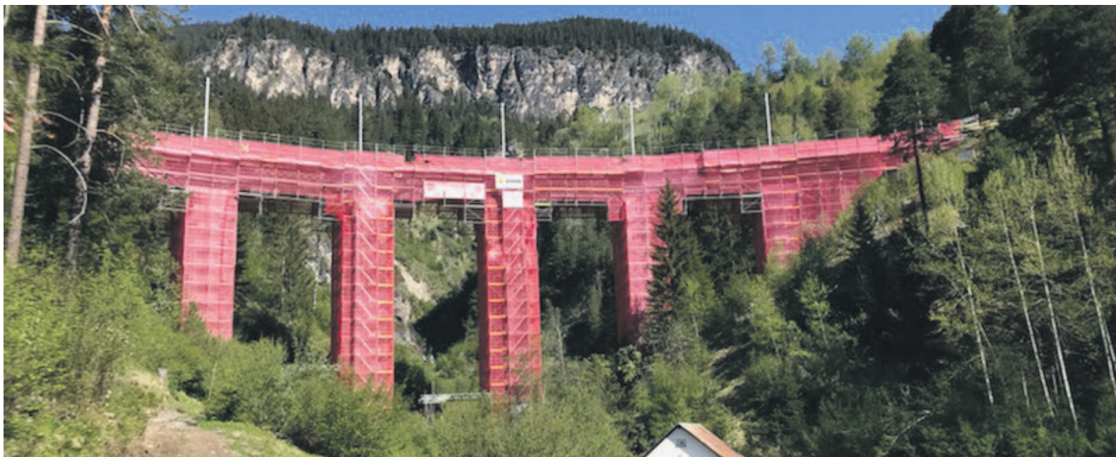
Auch andernorts wird tüchtig gearbeitet: Schmittnertobelbrücke der RhB im Gerüst.
