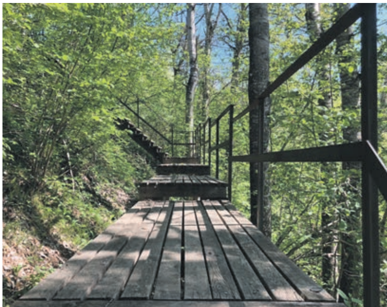
Die erneuerten Stegpartien.
