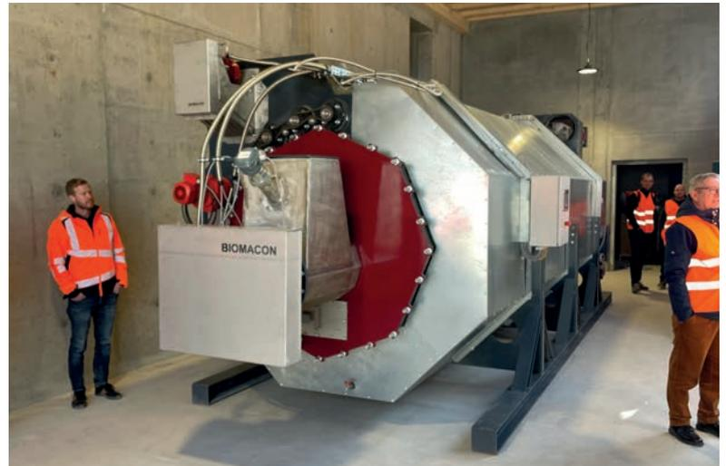
In diesem Biomacon werden zur Zeit pro Jahr 500 Tonnen Pflanzenkohle hergestellt, und zwar mit einem Pyrolyseverfahren.
