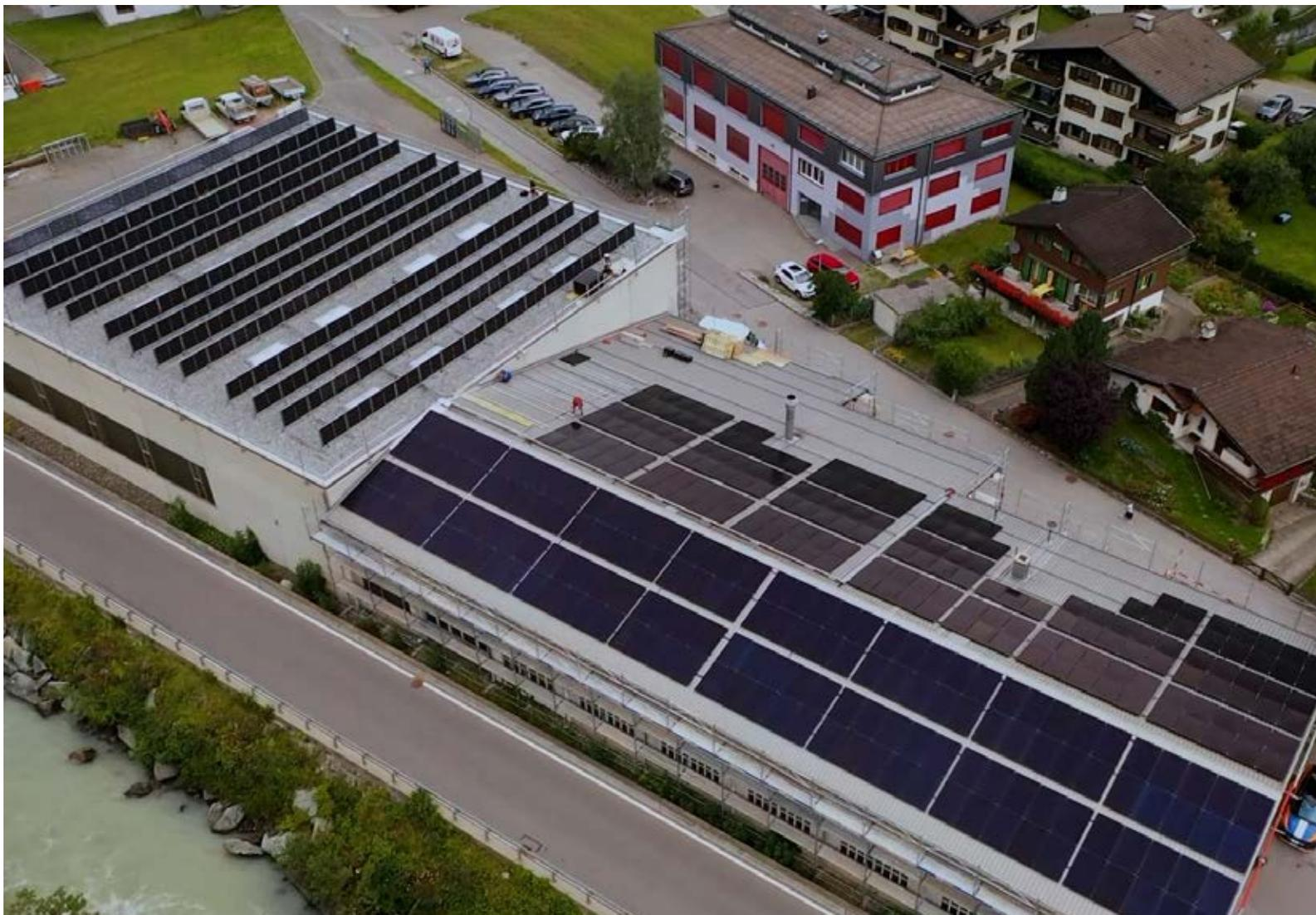
Insgesamt wurden in diesem Sommer 1110 Solar-Panels installiert. Sie liefern pro Jahr 230 000 kWh Strom.
