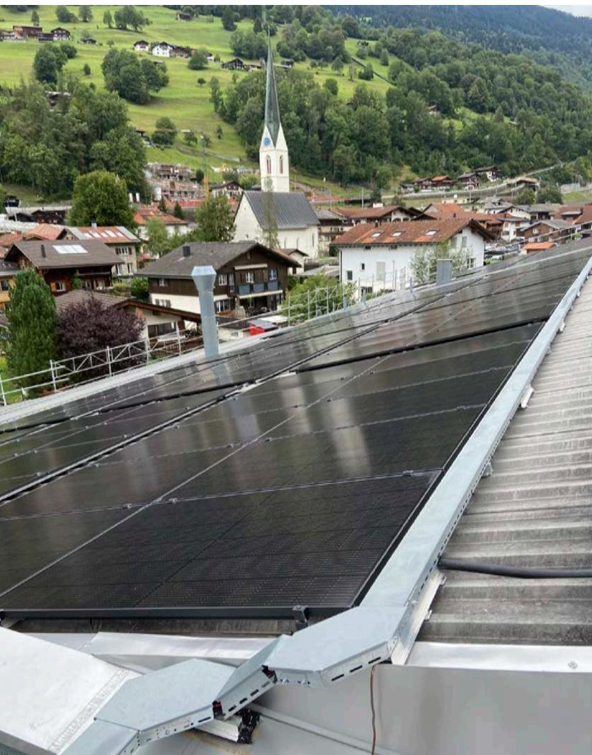
Eine wichtige Erkenntnis: Der Wirkungsgrad der senkrechten Panels ist grösser als bei denen in Schräglage (Bild links). Diese bifazialen Module produzieren beidseitig Strom und der Schnee bleibt im Winter nicht liegen.
