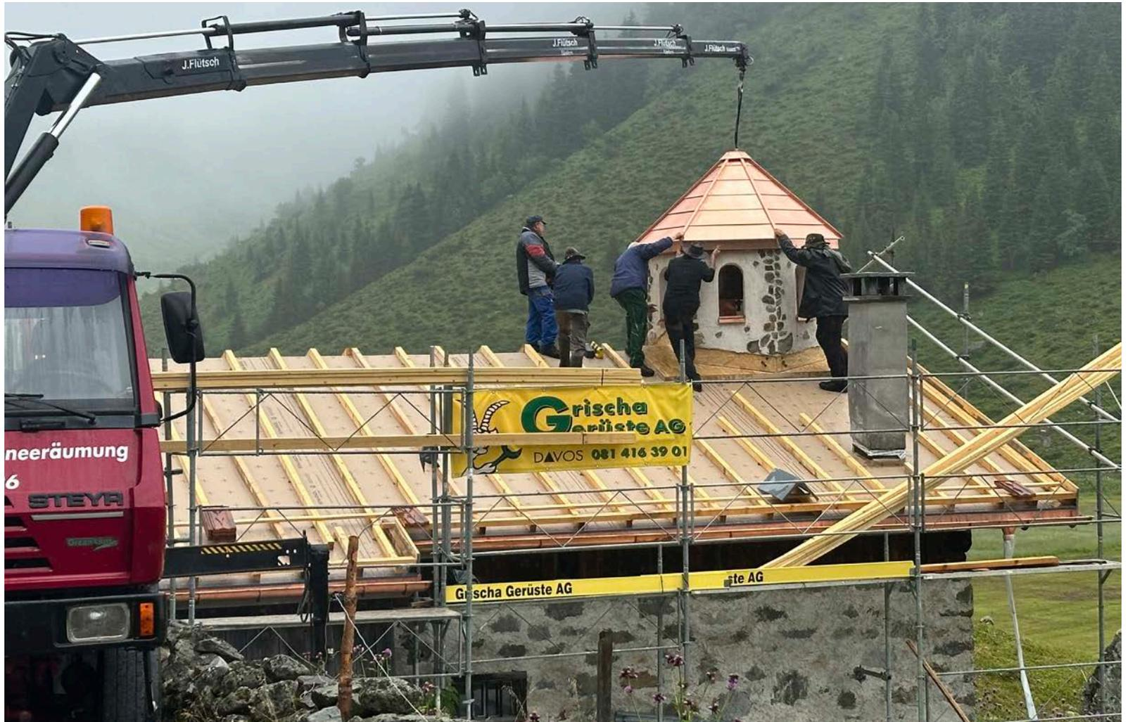
Der Lastwagenkran von Jöri Flutsch setzt das Kupferdach millimetergenau auf das Türmchen.
