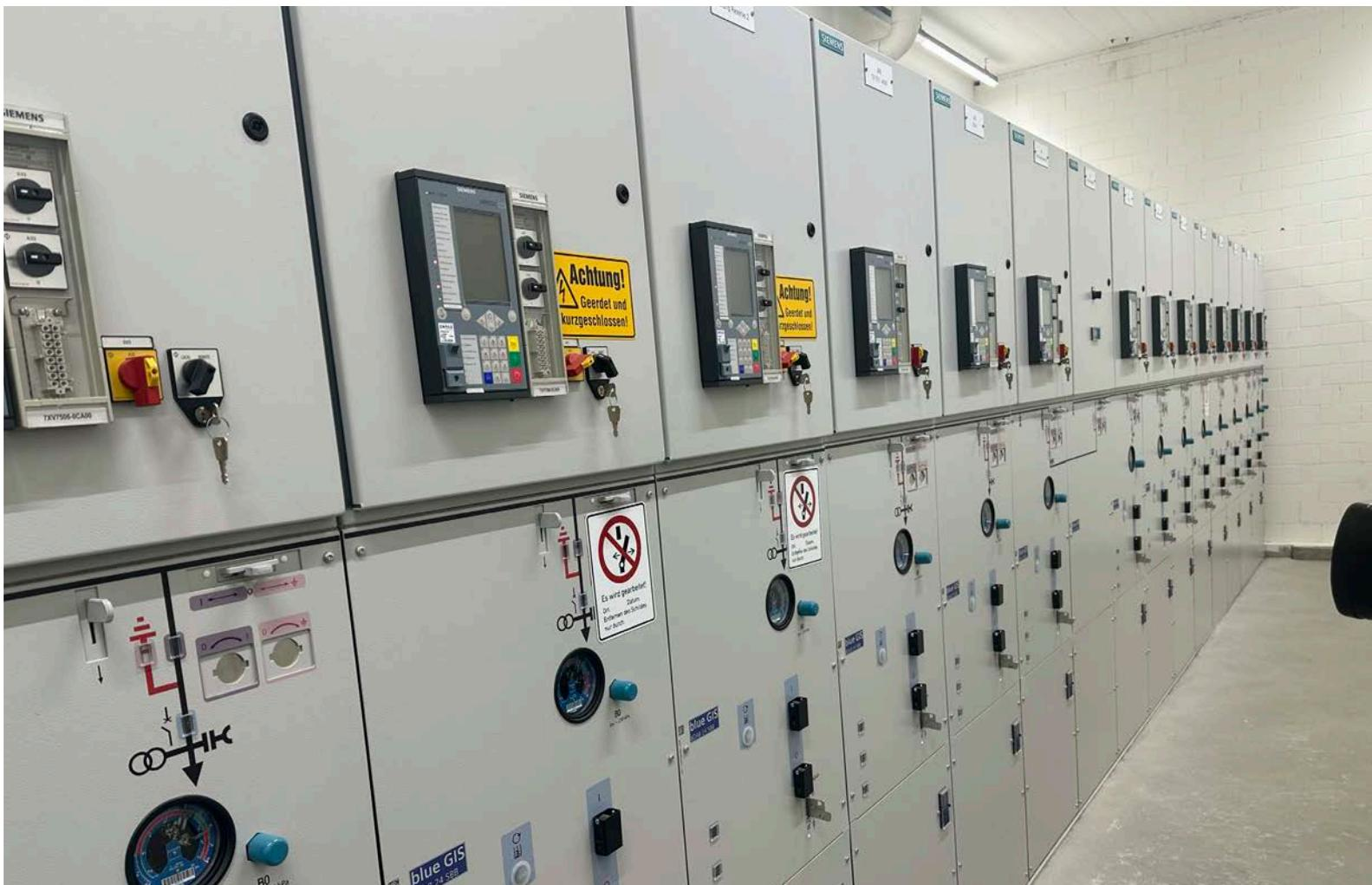
Die 24-kV-Schaltanlage von Siemens im Unterwerk Davos Dorf.
