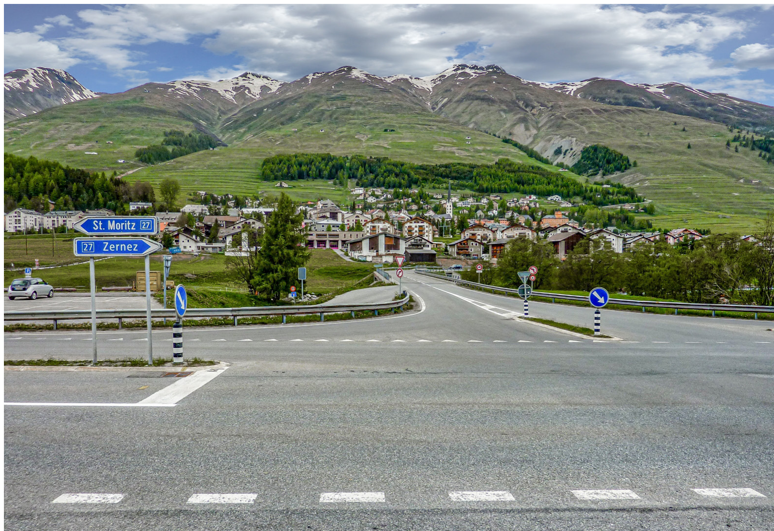
Anschluss Zuoz: Hier wird in diesem Sommer ein Kreisel gebaut.
